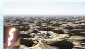
路探1井放喷现场
